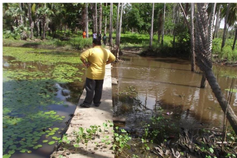
Figura 9. Barragem do tipo Passagem Molhada no Rio Portinho
