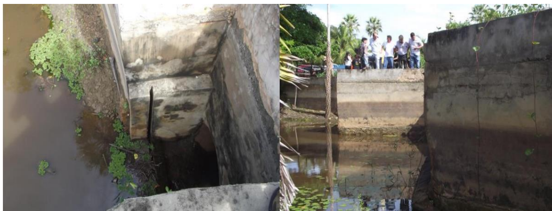
Figura 10. Fotografias da Barragem com comporta no Rio Portinho
